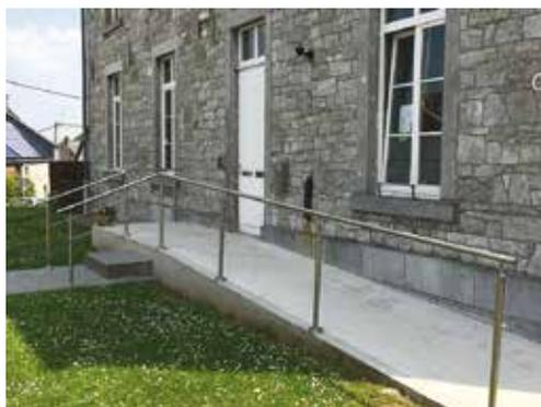
Au CPAS, une nouvelle main courante a été installée par les ouvriers pour sécuriser l'accès PMR au bâtiment principal.
